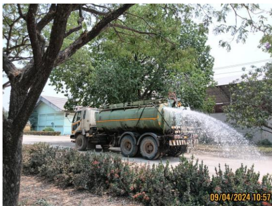
รูปที่ 3-5 การฉีดพรมน้ำเส้นทางลำเลียงแร่ภายในพื้นที่โครงการ
